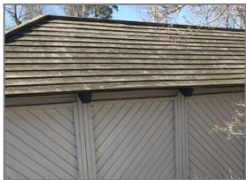
Tässä pienessä varastorakennuksessa on käytetty katemateriaalina puulaudoitusta.
