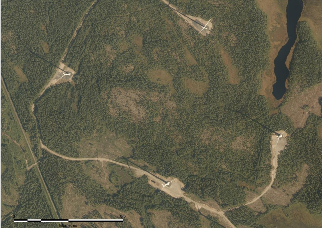
Kuva 2-7. Esimerkkikuva toiminnassa olevasta tuulivoimapuistosta. Tuulivoimaloita varten on rakennettu huoltotiet ja nostokentät. Tuulivoimaloiden ympäristössä ja välialueilla aikaisempi maankäyttö on säilynyt ennallaan.
