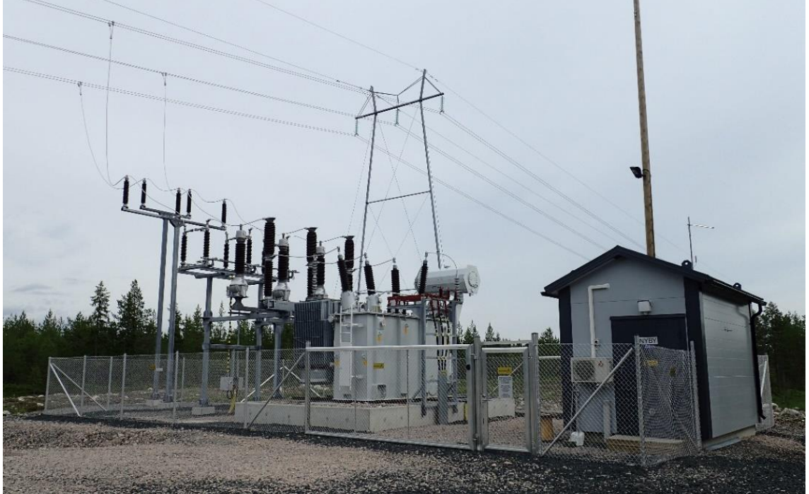
Kuva 2-13. Esimerkki tuulivoimapuiston sähköasemasta.
