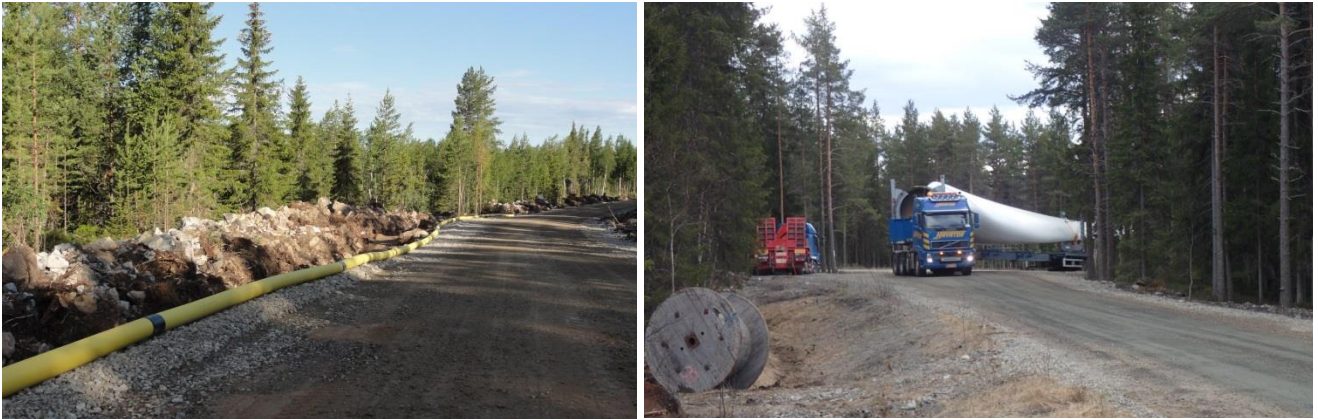
Kuvapari 2-12. Vasemmalla: Esimerkki tuulivoimapuiston rakennus- ja huoltotiestä. Maakaapeli sijoitetaan ojakaivantoon tien reuna-alueelle. Oikealla: Tuulivoimalan osia kuljetetaan erikoiskuljetuksina. (Kuvat: Ville Suorsa, FCG).
