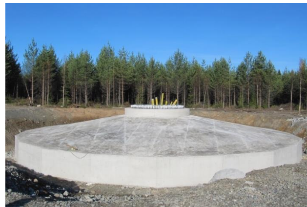
Kuvapari 2-16. Tuulivoimalan perustusten rakentamista. (Kuvat: Leila Väyrynen, FCG)
