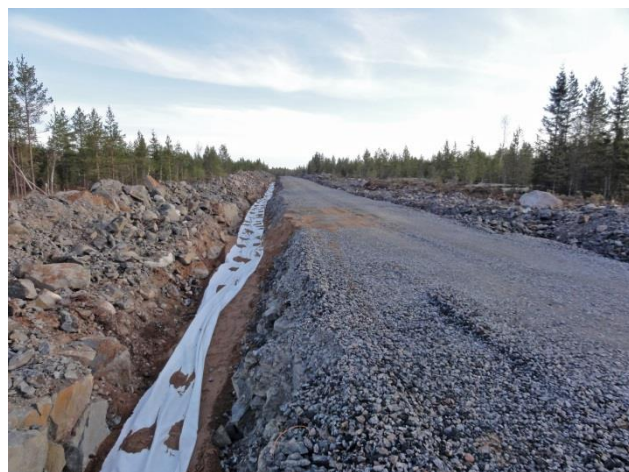
Kuvapari 2-15. Maakaapelit upotetaan huoltoteiden yhteyteen (Kuvat: Ville Suorsa, FCG).
