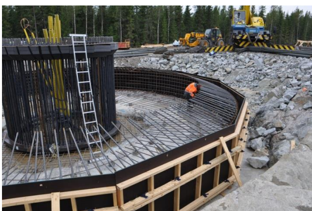
Kuvapari 2-16. Tuulivoimalan perustusten rakentamista. (Kuvat: Leila Väyrynen, FCG)
