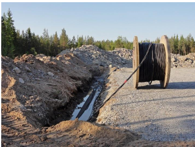
Kuvapari 2-15. Maakaapelit upotetaan huoltoteiden yhteyteen (Kuvat: Ville Suorsa, FCG).
