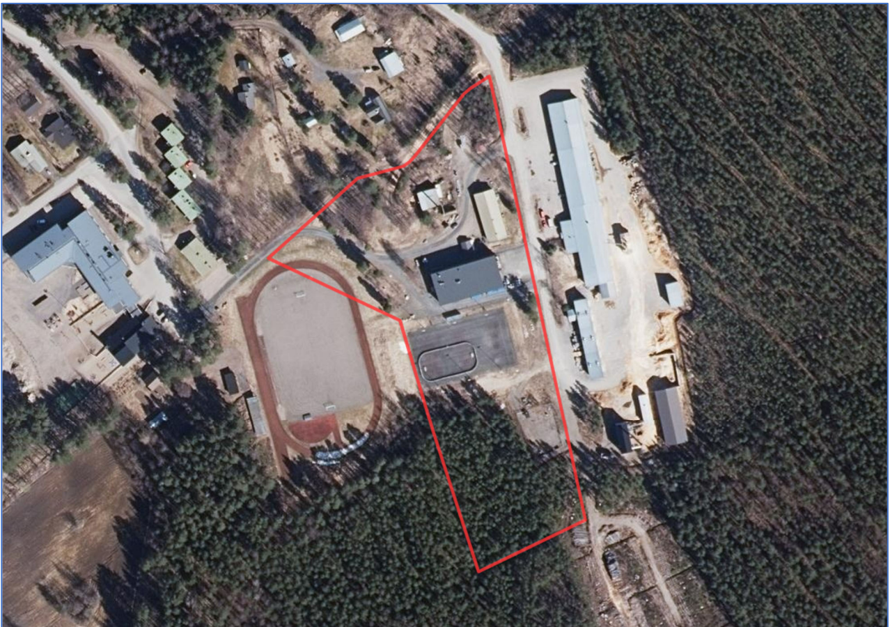
Kuva 11. Ortoilmakuva suunnittelualueelta (2020). Nykytilanteessa eteläosan metsäalue on hakattu. (Ortokuva © MML)
