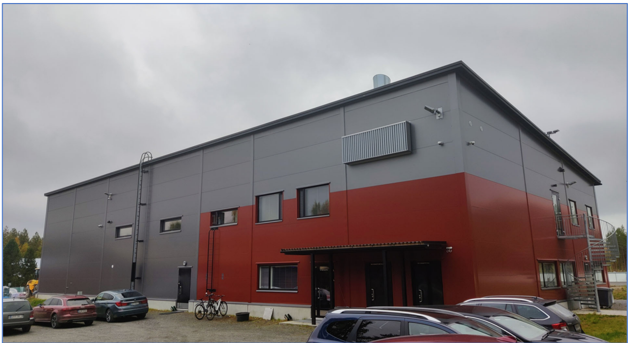
Kuva 5. Uusi rakennus varavoimalaitoksen ja varastorakennuksen eteläpuolella. (© Plandea Oy)
